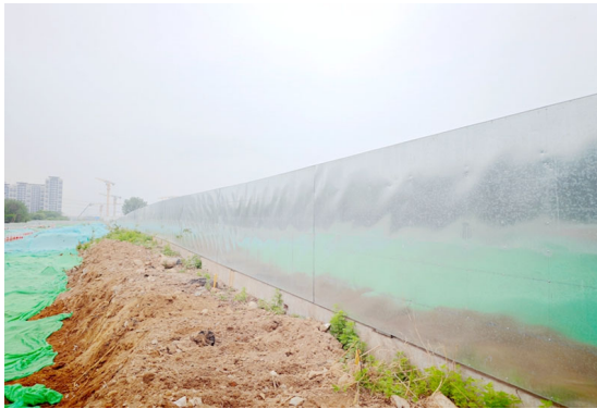
项目西侧围挡
