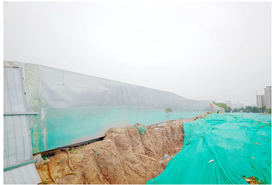
项目北侧围挡
