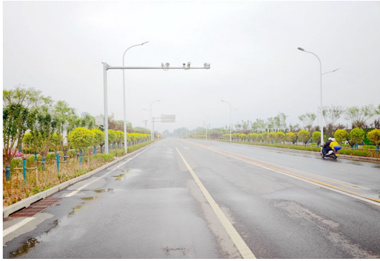
项目东侧现状道路
